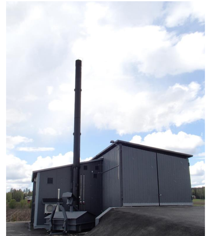
Abb. 4: Reine Heizkesselanlage in einem dünn besiedelten Gebiet. Quelle: Thermopolis [1]
