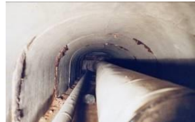
Abbildung 2: Kanalverlegeverfahren. Quelle: AGFW [1]
