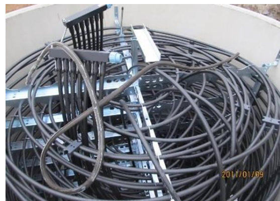
Abbildung 2: leerer Solareisspeicher mit Wärmetauscherrohren. Quelle: ZEBAU GmbH [2]
