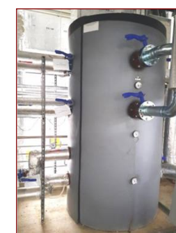
Rys. 11: Widok ogólny instalacji odzysku ciepła odpadowego oraz zbiornika buforowego. Źródło: D. Formela – IMP PAN Gdańsk
