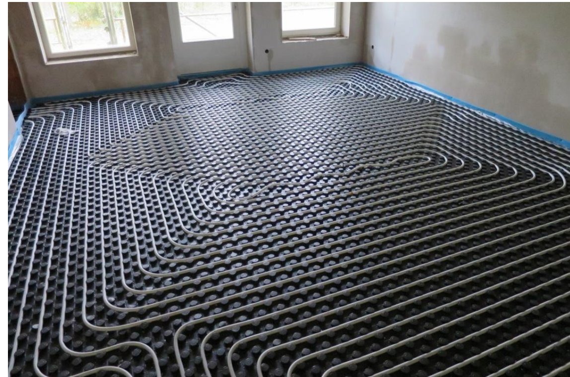
Abbildung 5: Fußbodenheizungsmatten mit Rohren. Quelle: ZEBAU GmbH [5]
