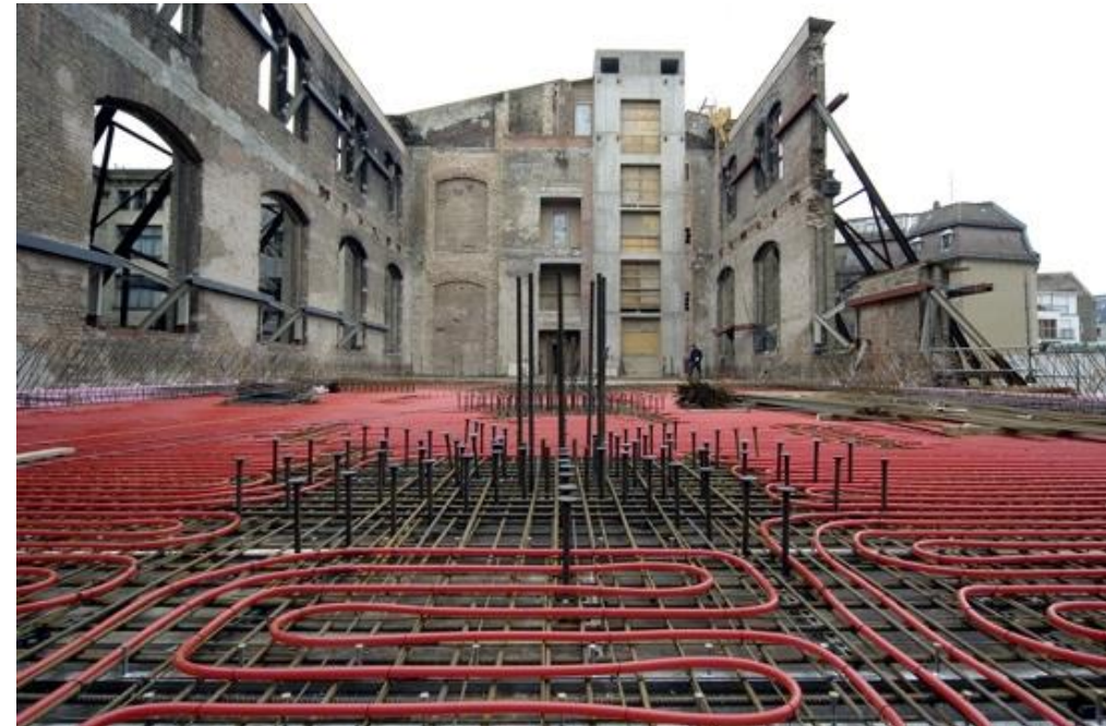
Abbildung 13: Installation einer Unterbodenheizung im Beton (Thermische Komponentenaktivierung). Quelle: InformationsZentrum Beton GmbH [10]
