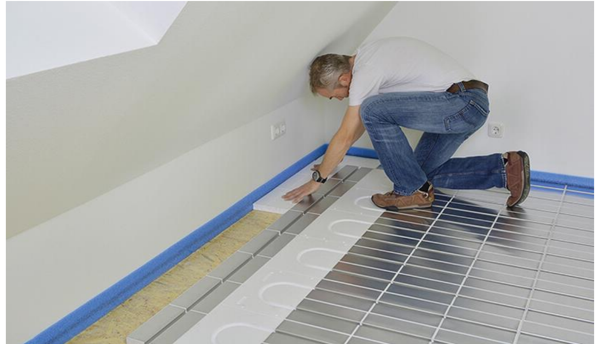
Abbildung 7: Trockenbauweise. Quelle: Quick Tec [6]
