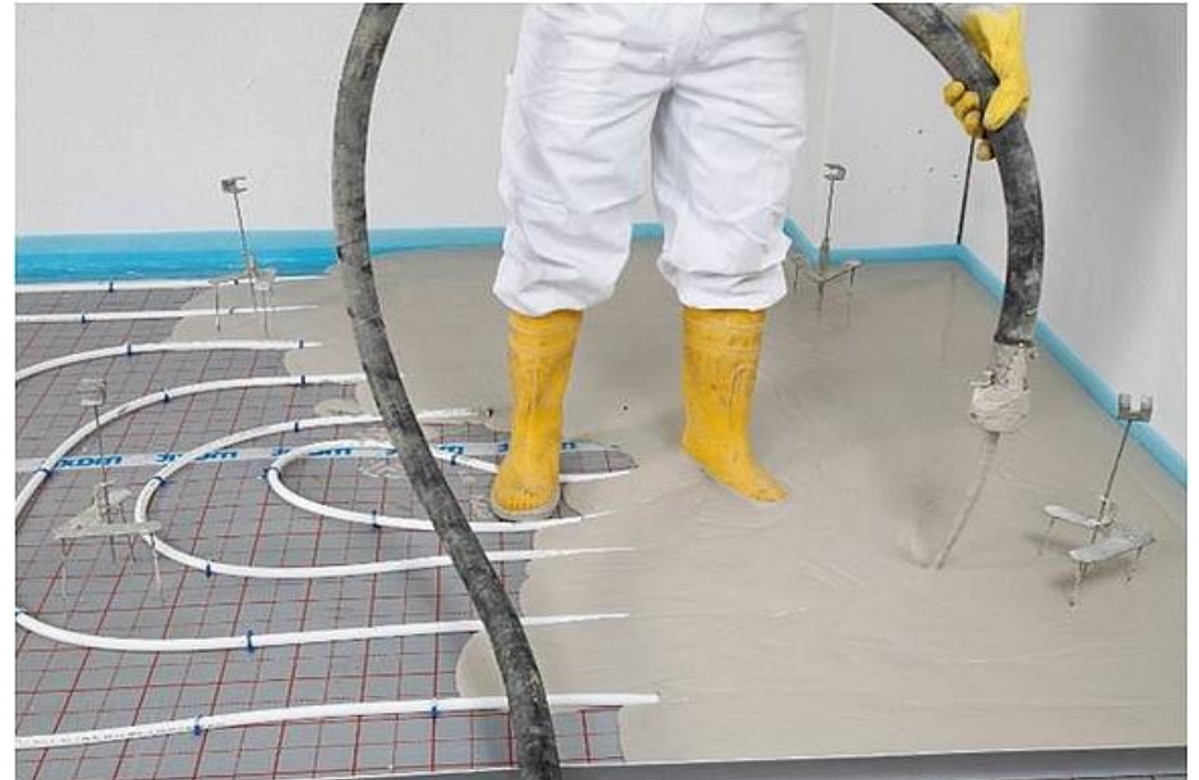
Abbildung 8: Nassbauweise. Source: Franken Maxit Mauermörtel GmbH & Co [7]
