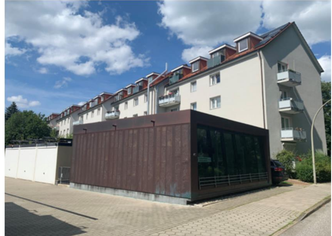
Abbildung 2: Energiezentrale mit Wärmepumpe am Reeseberg. Quelle: ZEBAU GmbH [2]
