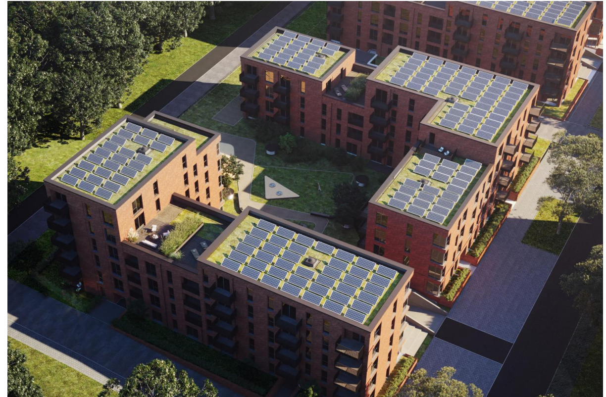
Abbildung 19: PV-Anlagen auf dem Dach der Gebäude. Quelle: FRANK [11]
