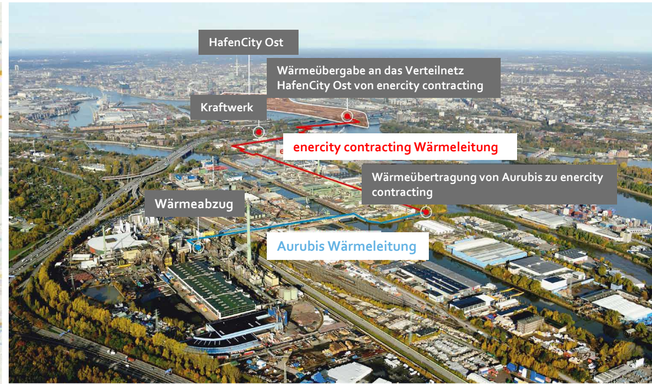
Abbildung 18: Fernwärmeleitungsstrasse vom Auribus-Werk zur HafenCity Ost. Quelle: Auribus AG [10]
