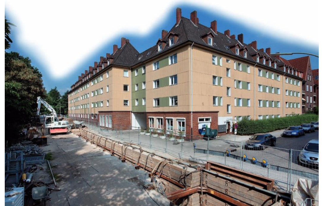
Abbildung 4: Baumaßnahmen am Siel. Quelle: Hamburg Wasser [3]
