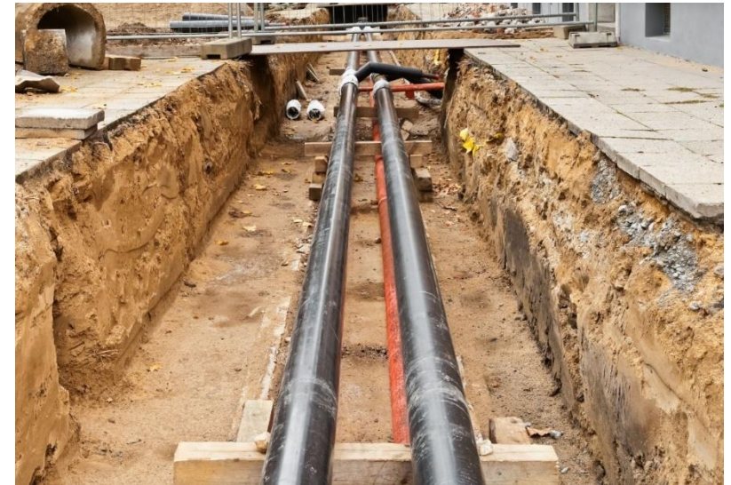
Montaż rur preizolowanych z płaszczem plastikowym w wykopie (Źródło: AdobeStock Image)
