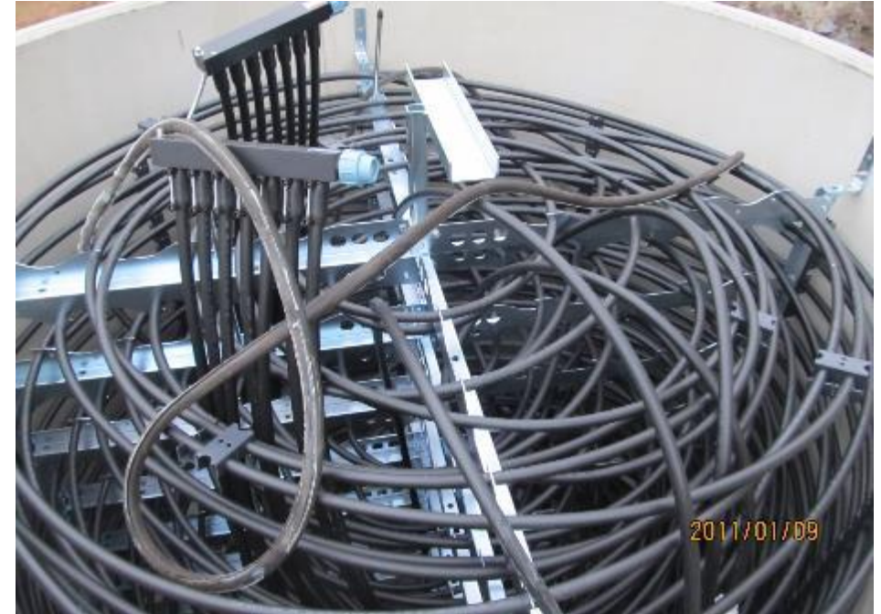
Abbildung 5: Eisspeicher Rohrleitungssystem. Quelle: ZEBAU GmbH [5]
