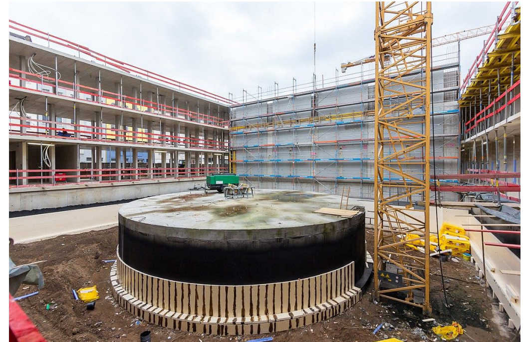
Abbildung 12: Eisspeicher in Konstruktion. Quelle: Raimond Spekking [12]
