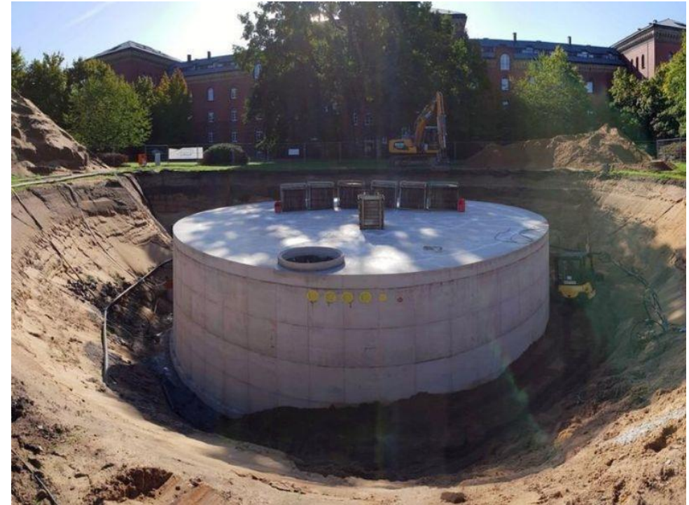
Abbildung 9: Eisspeicher von Außen. Quelle: Stadtwerke Rendsburg GmbH [9]
