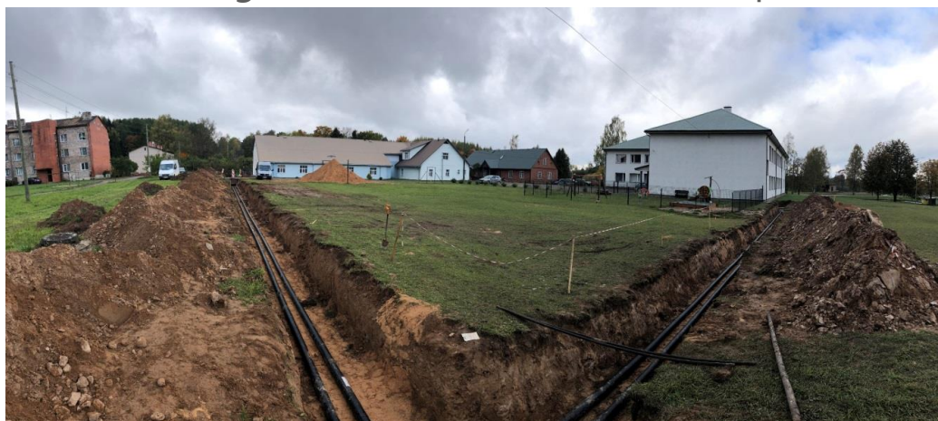
Abb. 24: Leitungsverlegung, eigenes Foto: V. Kirsanovs [6]
