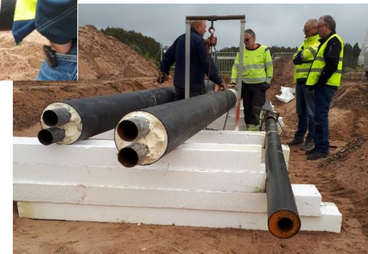
Abb. 8: Feldtest zur richtigen Positionierung der Rohre [4]
