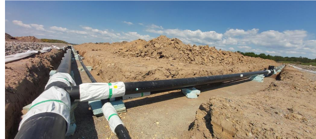
Abb. 13: Arbeiten zum Anschluss 4 G FW – 3R Netz [4]
