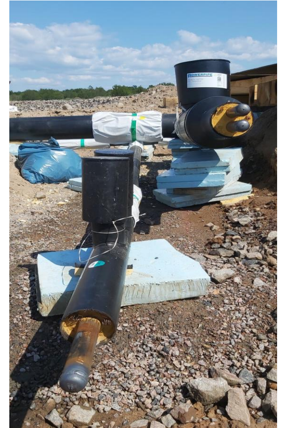
Abb. 15: Installation des Leitungsnetzes [4]
