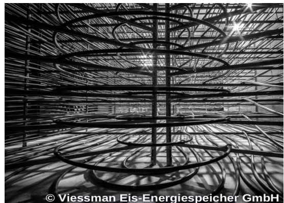
Figur 2: Tom islagringsenhet med värmeväxlarrör. Källa: Viessmann
