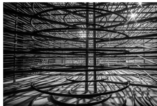
Рис 2: Система труб установки ледохранилища, источник: Viessmann
