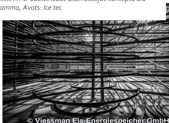
Attēls nr. 2: Tukša saules ledus uzglabāšanas iekārta ar siltummaiņas caurulēm, Avots: Viessmann
