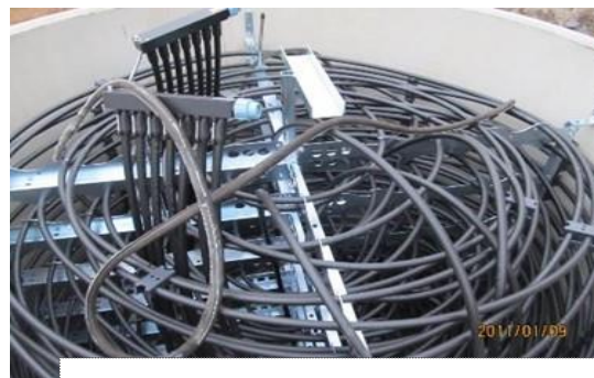
Kuva 2: Tyhjä aurinkoenergia-jäävarasto ja lämmönvaihdinputkia. Lähde: ZEBAU GmbH [2]
