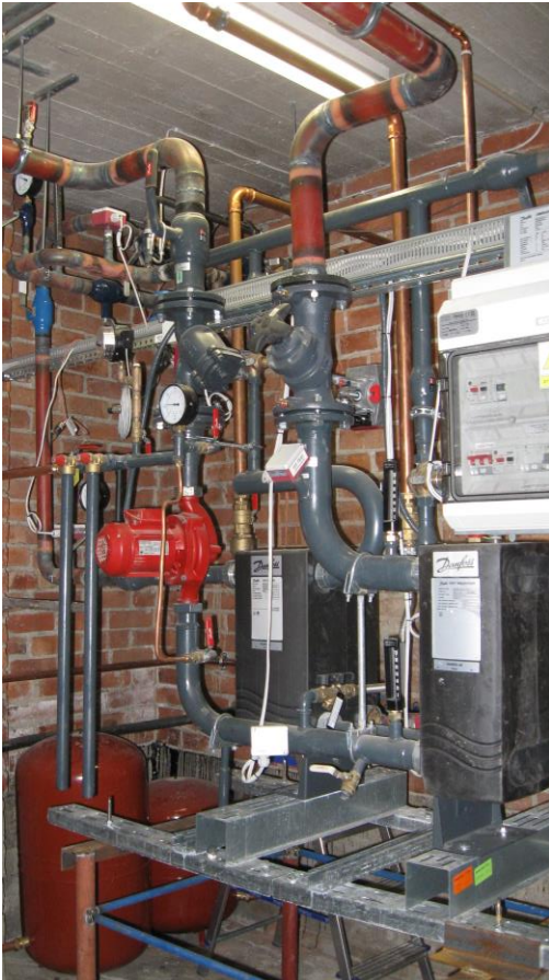
Kuva 2: Asiakkaan liitännä kaukolämpöverkkoon. Lähde: Thermopoliksen kuva-arkisto [1]
