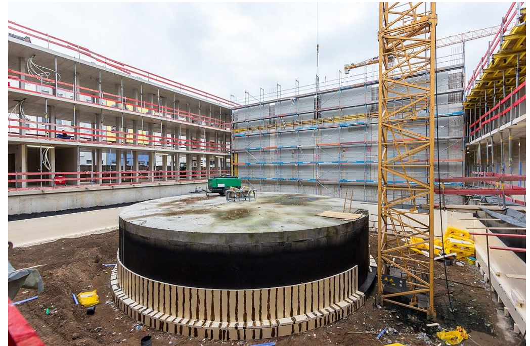
Kuva 10: Rakenteilla oleva jäävarasto. Lähde: Raimond Spekking [11]
