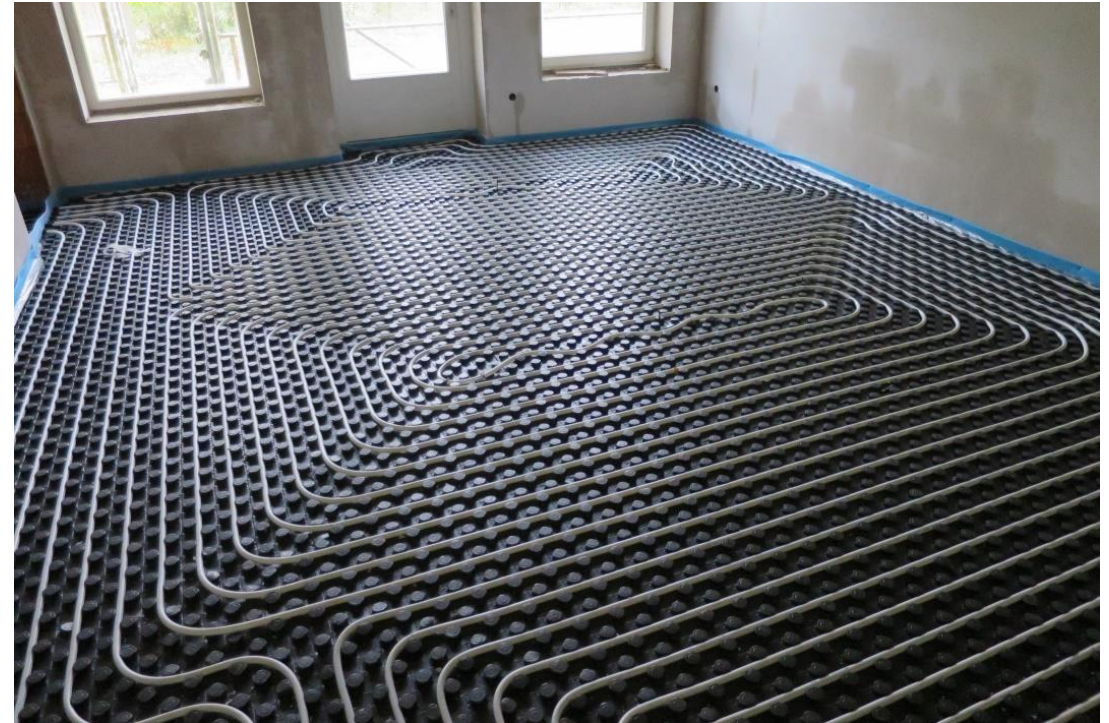
Kuva 5: Lattialämmitysmattoja putkineen, lähde: © ZEBAU GmbH
