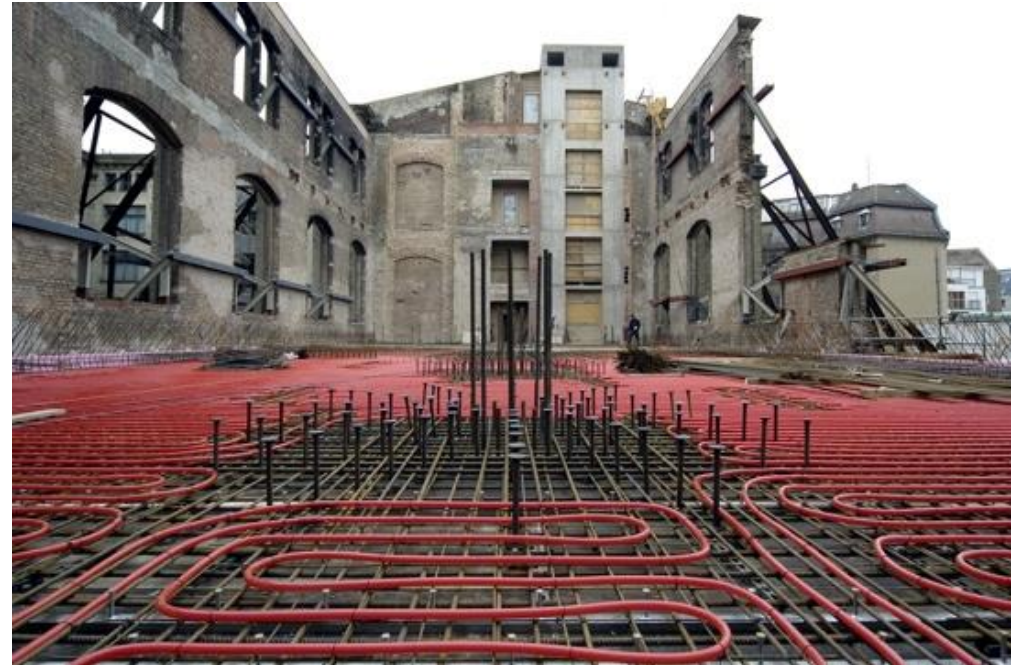
Kuva 13: lattialämmityksen asentaminen betoniin (komponenttien lämpöaktivointi), lähde: beton-campus.de
