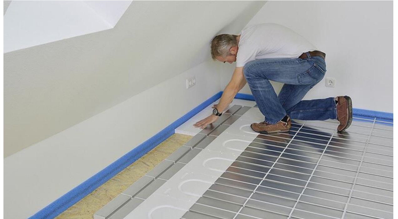
Kuva 7: Kuiva-asennus, lähde: quicktherm-fußbodenheizung.de
