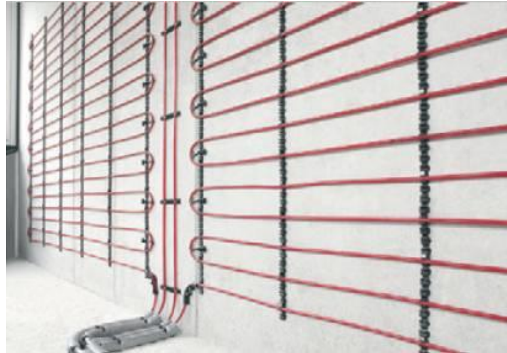
Kuva 12: seinälämmitysjärjestelmä, lähde: Rehau
