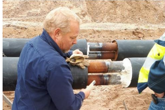
Kuva 6 – Hitsauskokeita. Lähde: Halmstads Energi och Miljö AB [4].
