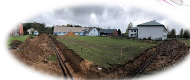
Kuva 1b: Kaukolämpöjärjestelmän uudistaminen Beļavan kylāssä. Lähde: Gulbenen kunta
