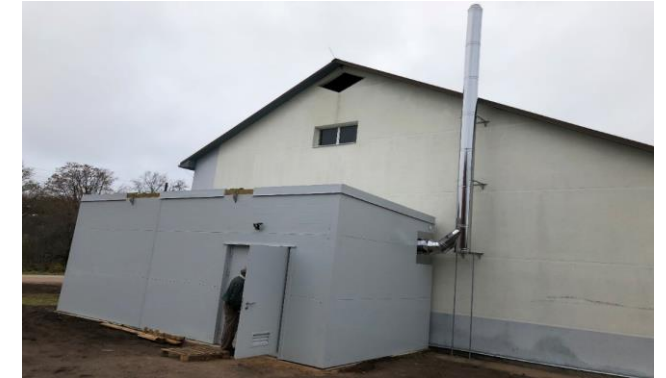
Kuva 21 : Belavan kylän uusi kattilahuone. Lähde: Gulbenen kunta [6].
