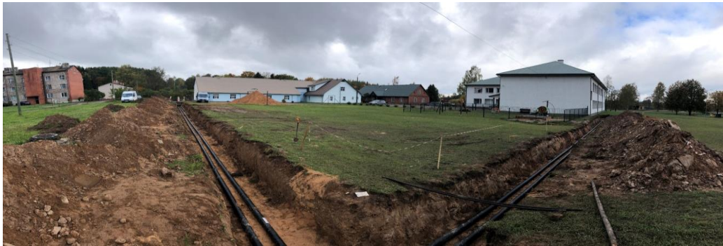
Kuva 23: Beļavan kylän kaukolämpöverkon uudistaminen. Lähde: Gulbenen kunta [2]
