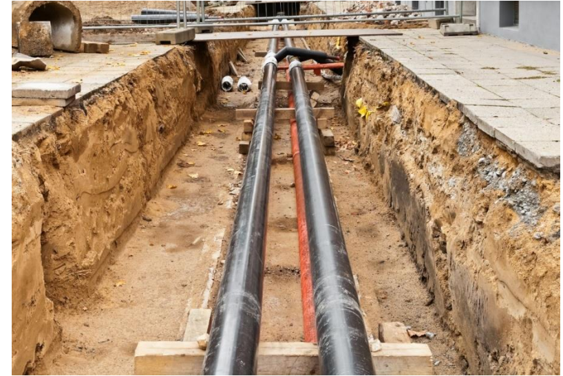
Muoviputkien asennus kaivantoasennusmenetelmällä (Lähde: AdobeStock Image)
