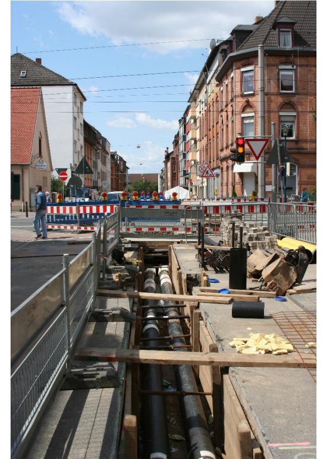
Esemukkeja kanava- ja kaivantoasennusmenetelmistä (Lähde: AGFW)
