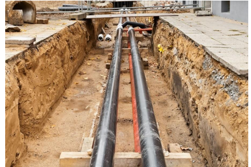
Muoviputkien asennus kaivantoasennusmenetelmällä (Lähde: AdobeStock Image)
