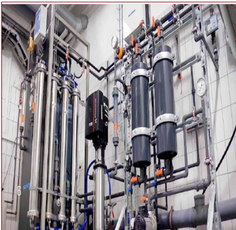
Rys. 21: Kompletna instalacja do produkcji wody dla sieci ciepłowniczej metodą odwróconej osmozy wraz ze zmiękczaczem i odgazowaniem membranowym. Źródło: EUROWATER Uzdatnianie wody [16]
