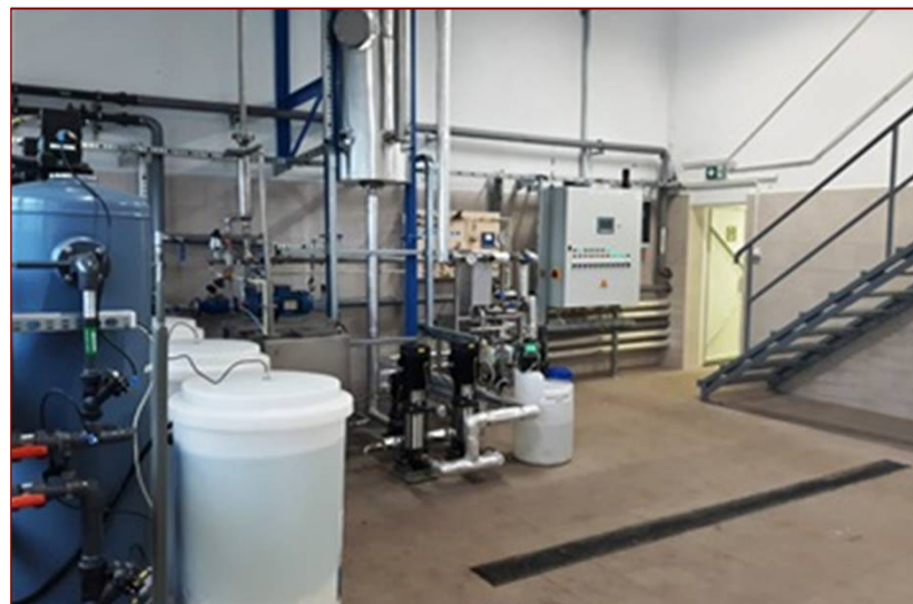
Rys. 24-25: Zmodernizowana w 2017 r. stacja uzdatniania wody dla miejskiej sieci ciepłowniczej w Lęborku. Źródło: MPEC Lębork [18]
