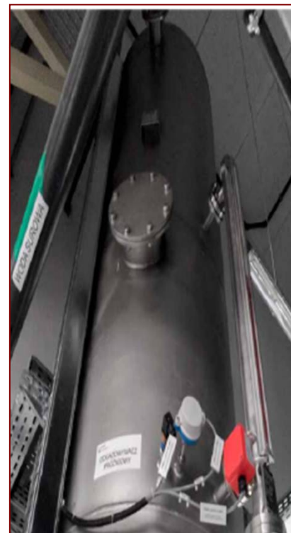
Rys. 22: Odgazowywacz próżniowy do usuwania rozpuszczonych gazów z wody. Źródło: EUROWATER Uzdatnianie wody [16]
