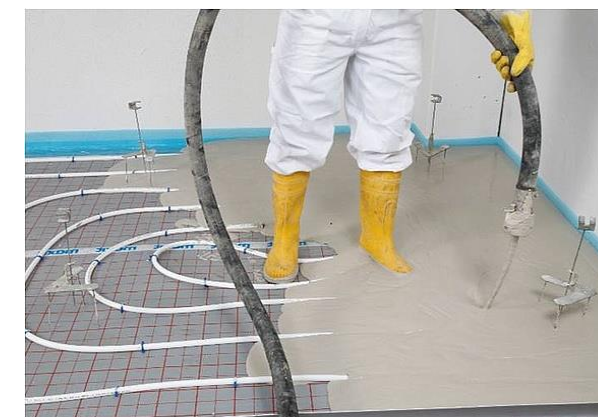
Fot.1. Konstrukcja na mokro,,źródło: www.baulinks.de
