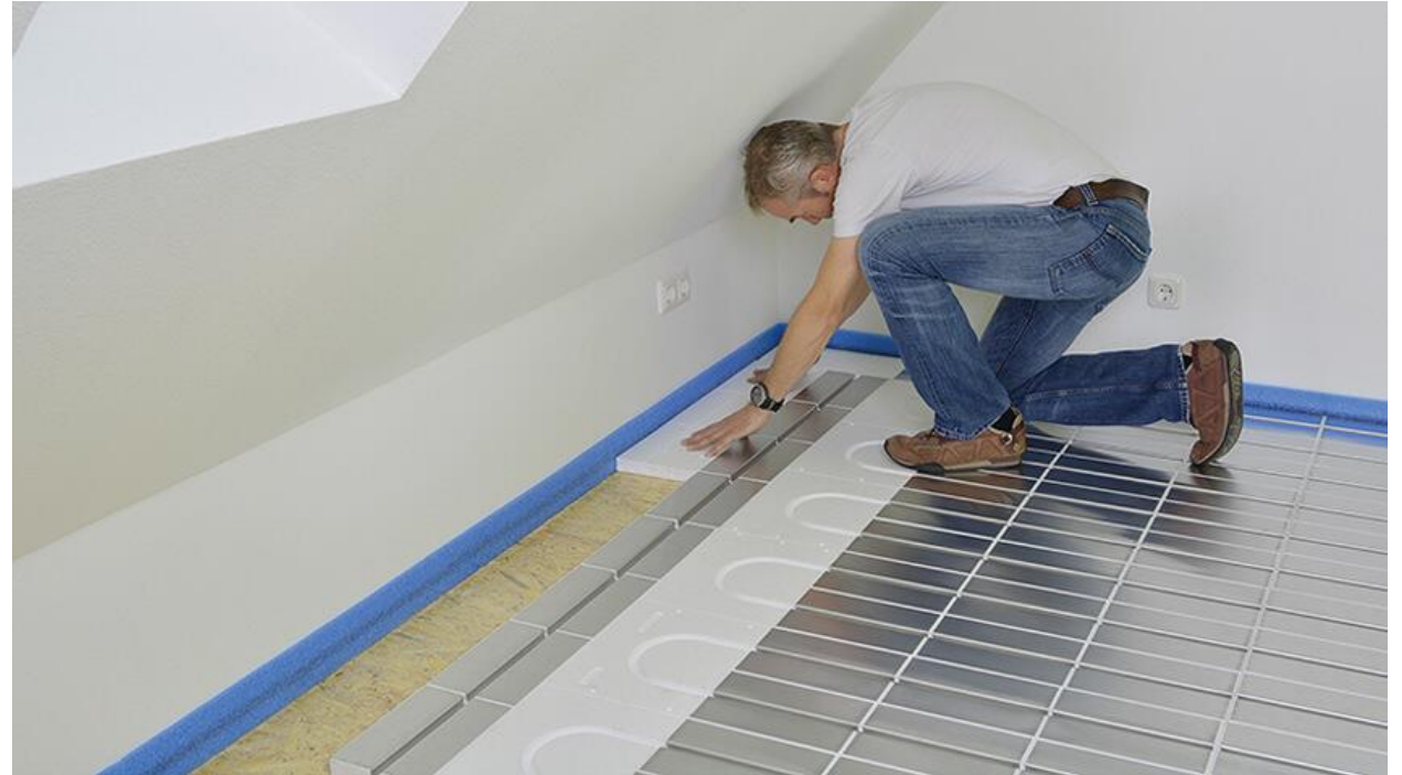
Rys. 7: Ogrzewanie podłogowe, konstrukcja sucha, źródło: quicktherm-fußbodenheizung.de
