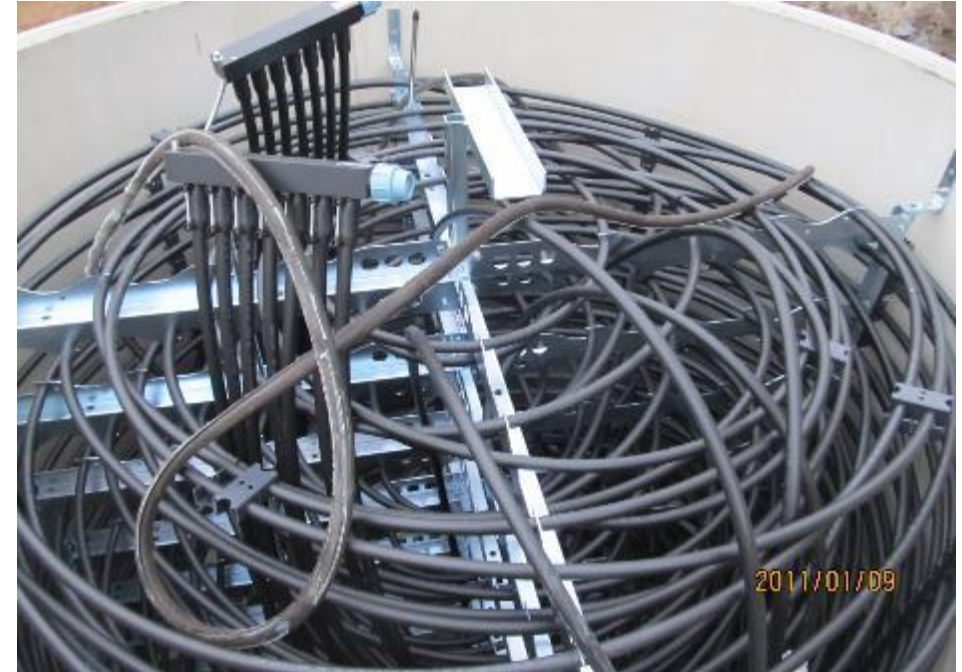
Rys. 5: Magazyn chłodu. Źródło: ZEBAU GmbH [5]
