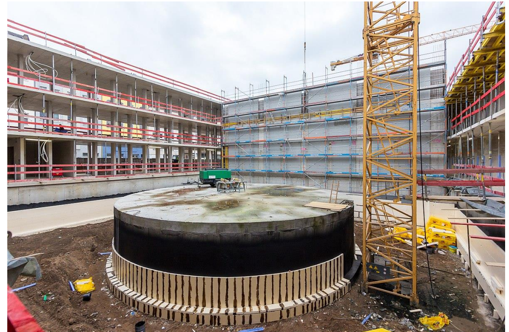
Rys. 11: Magazyn ciepła w budowie. Źródło: Raimond Spekking [11]
