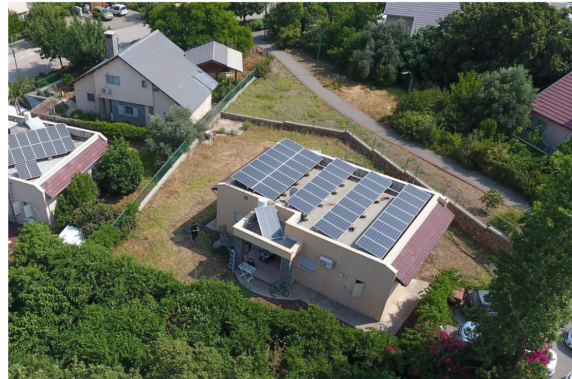
Rys. 4: Kolektory słoneczne. Źródło: Imtsimon [4]
