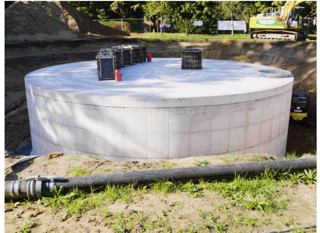
Rys. 8: Magazyn lodu. Źródło: Stadtwerke Rendsburg GmbH [8]
