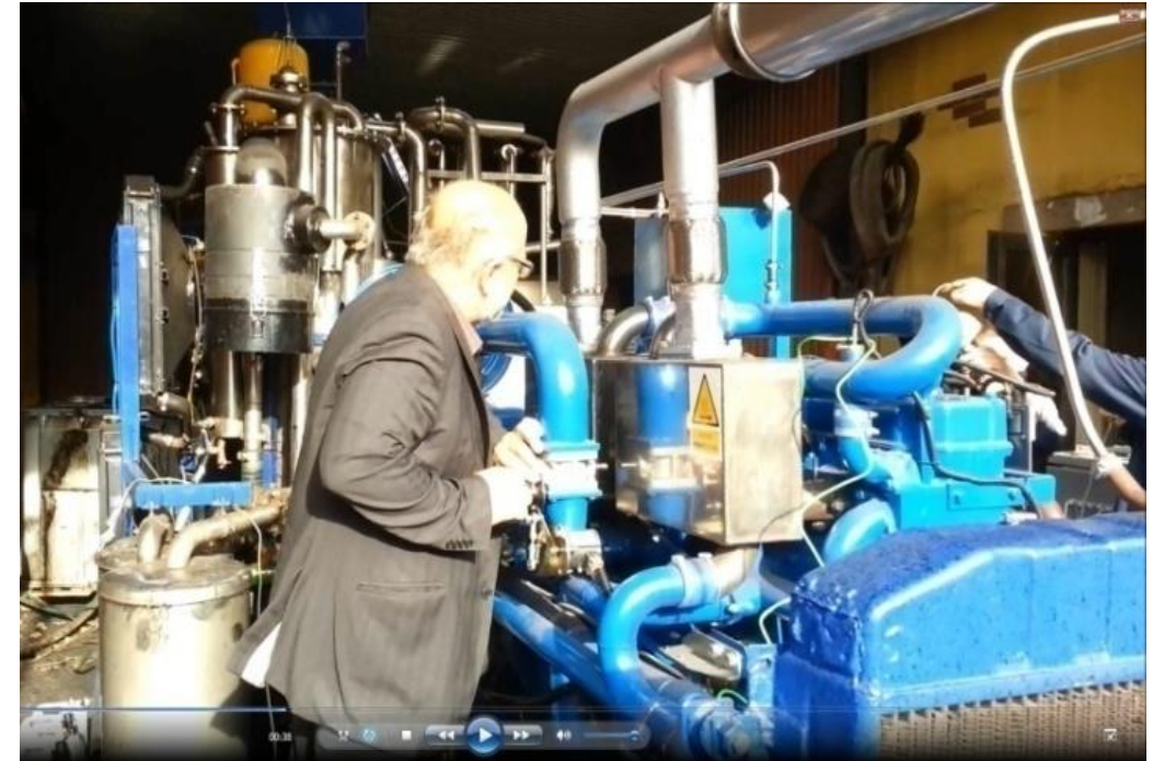
5 pav. 50 kW kogeneracinis įrenginys; šaltinis: A.Cenian, IMP PAN
