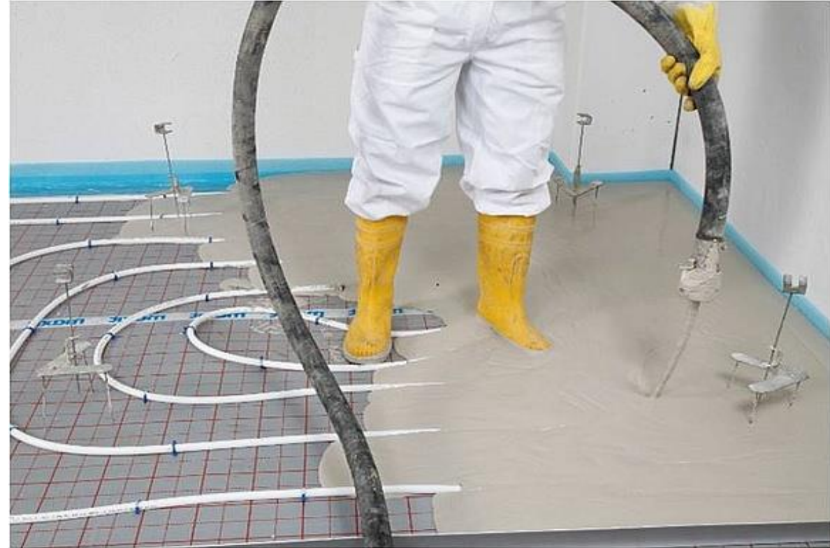
Рис 8: «Мокрое» строительство, источник: www.baulinks.de
