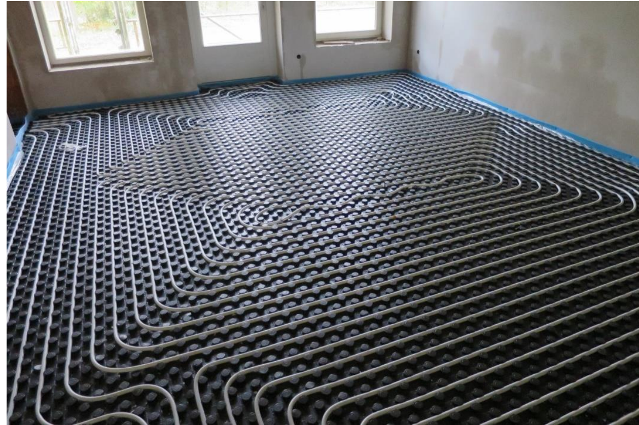
Рис 5: Коврики для подогрева пола с трубками, источник: © ZEBAU GmbH
