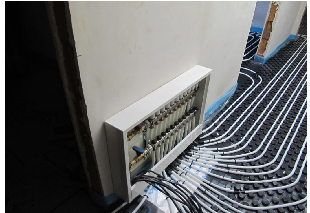
6 pav.: Grindinio šildymo kontūro skirstytuvai, šaltinis : ZEBAU GmbH [5]
