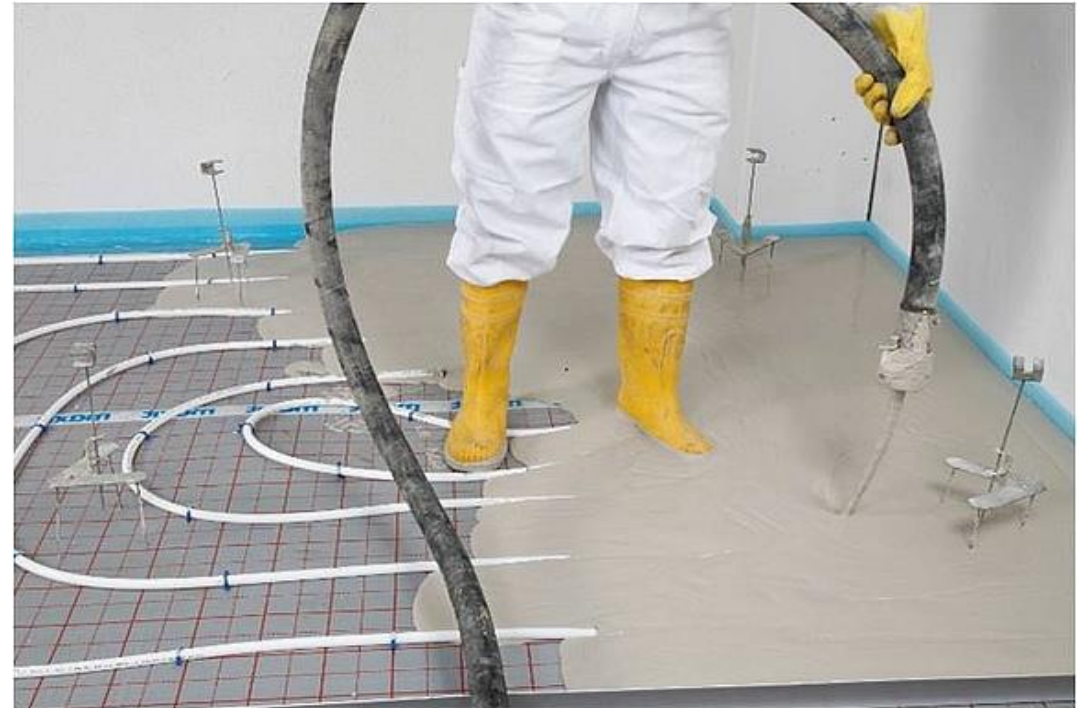
8 pav.: Šlapias klojimas, šaltinis: Franken Maxit Mauermörtel GmbH & Co [7]
