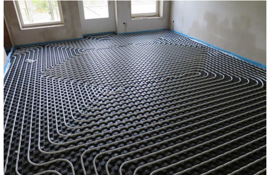
5 pav.: Grandinio šildymo kilimėliai su vamzdžiais, šaltinis: ZEBAU GmbH [5]
