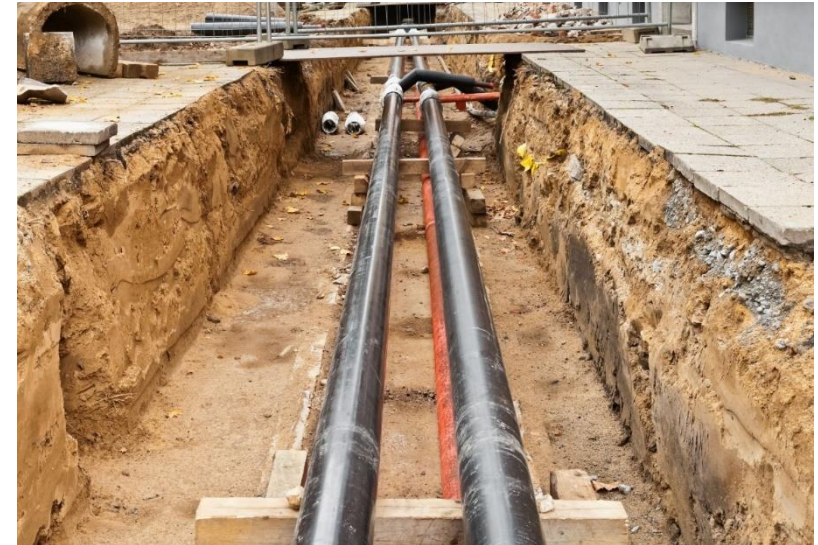
Installation af plastjakerør med grøftemetoden (Kilde: AdobeStock Image)
