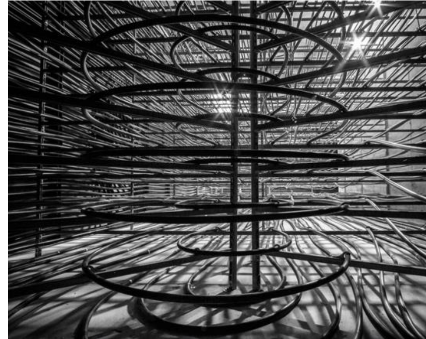
Joonis 5: Jäähoidla torustikusüsteem allikas: Viessmann, © ZEBAU GmbH
