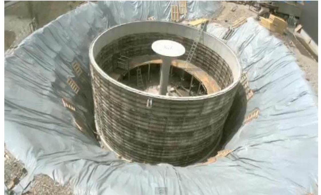
Joonis 9: Ehitatav jäähoidla, allikas: solaricetec.com
