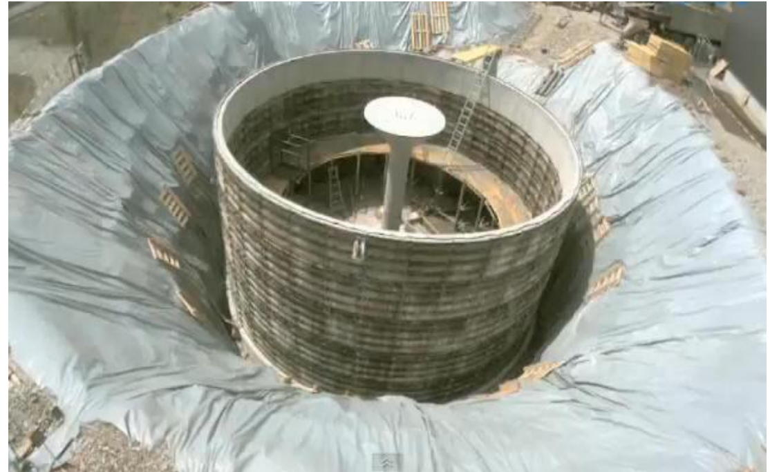
Рис 9: Ледохранилище в процессе постройки, source: solaricetec.com
