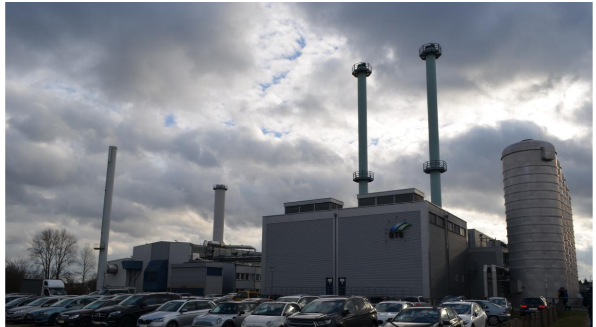
Rys. 8. EC Adlershof i instalacja Power-to-Heat © Ieva Pakere, RTU, Łotwa
