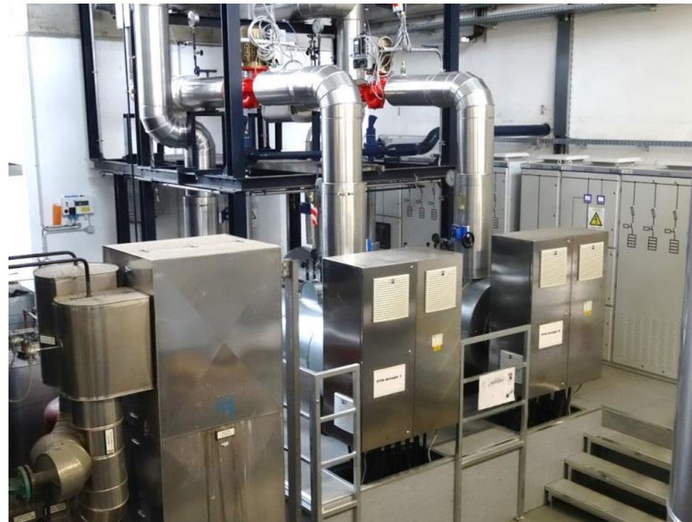
Rys. 9. EC Adlershof i rurowe podgrzewacze wody © a.v.e. – Energieberatungs- und Planungsgesellschaft mbH, Berlin [6]
